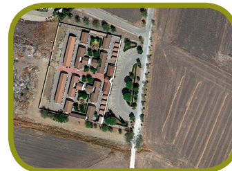
Acceso desde Fuentes de Andalucía 37.447231, -5.346410 Coordenadas GPS (formato decimal)
